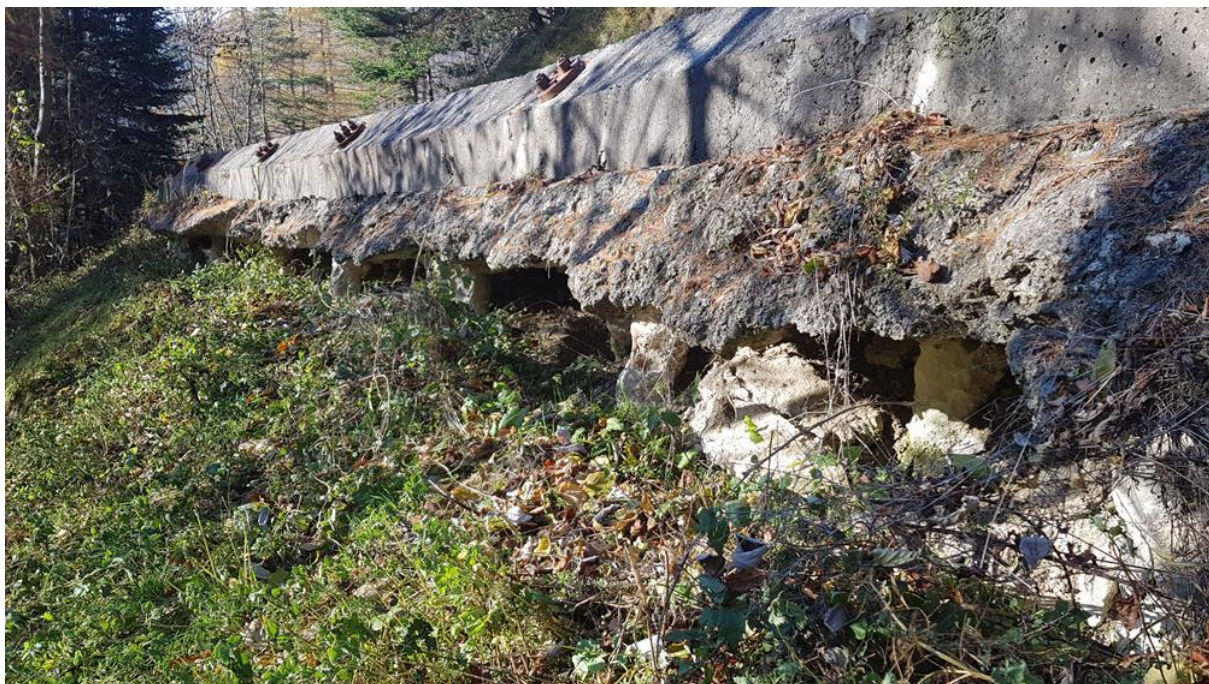
immagine 3: vista palificata strada Toria – particolare del cedimento a valle e di teste di ancoraggio parzialmente sfilate
