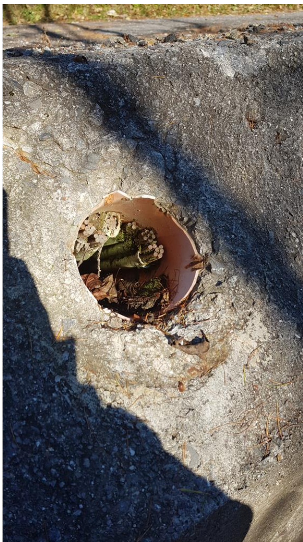
immagine 5a-b: vista palificata strada Toria – particolare tirante con testa sfilata e vista micropali
