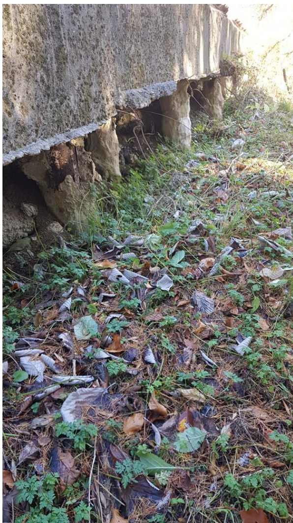
immagine 5a-b: vista palificata strada Toria – particolare tirante con testa sfilata e vista micropali
