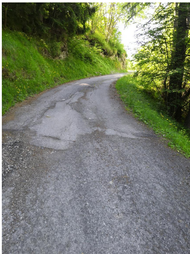
immagine 6a-b: vista dell'asfalto dissestato sulla strada di collegamento per la fraz. Toria
