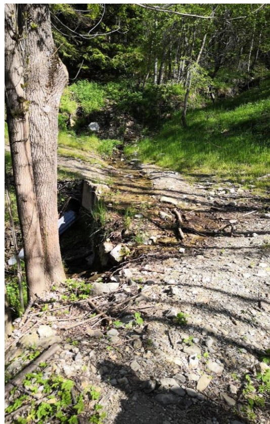
immagine 9a-b: vista tratti dissestati strada Cucchera – regimazione acque da palificata e ripristino attraversamento in loc. casa bruciata
