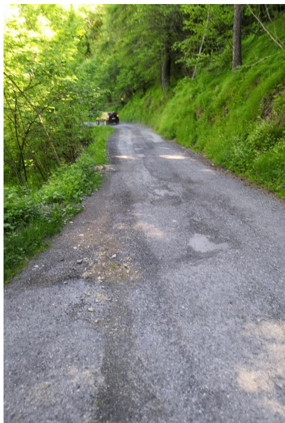
immagine 6a-b: vista dell'asfalto dissestato sulla strada di collegamento per la fraz. Toria
