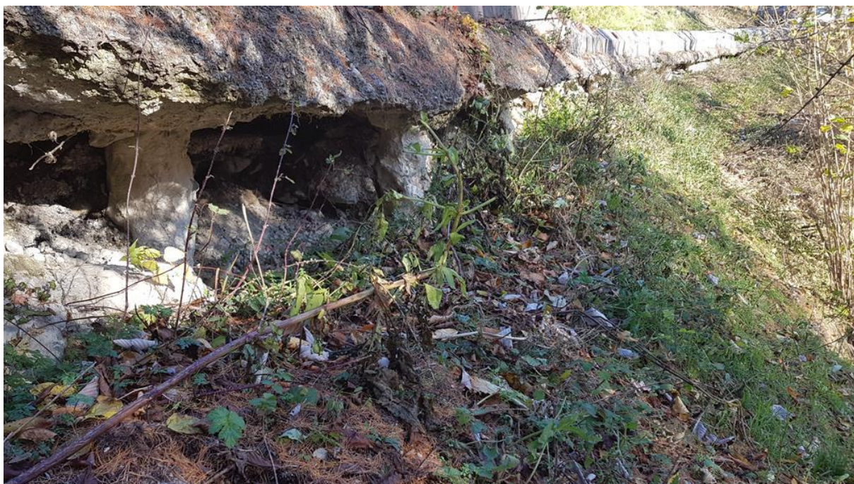
immagine 4: vista palificata strada Toria – particolare del cedimento a valle e di teste di ancoraggio parzialmente sfilate
